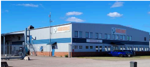
Härdservice Norden AB, Huvudkontor & produktion, Halmstad, anläggning byggd 2005
